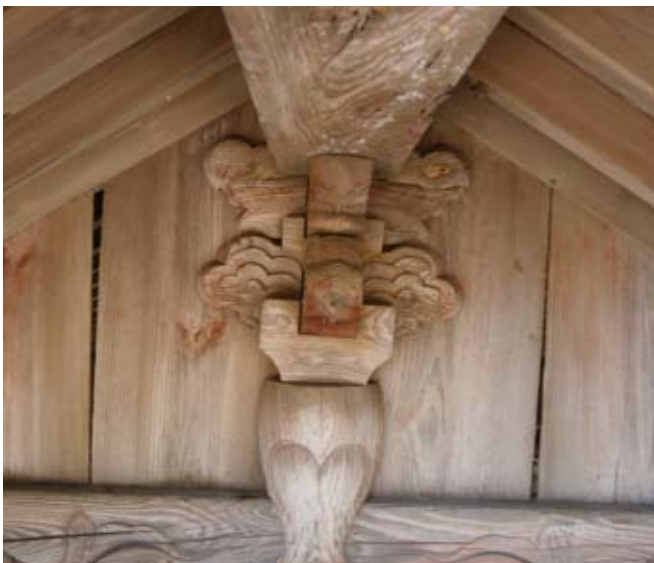
基本的には在来の木組で強度を追求。組物も忠実に再現された。左は旧山門、右は復元された山門（『杖珠院山門復元工事全記録』© KOBO OBA, Kaori Sanuki 2012 より抜粋）
