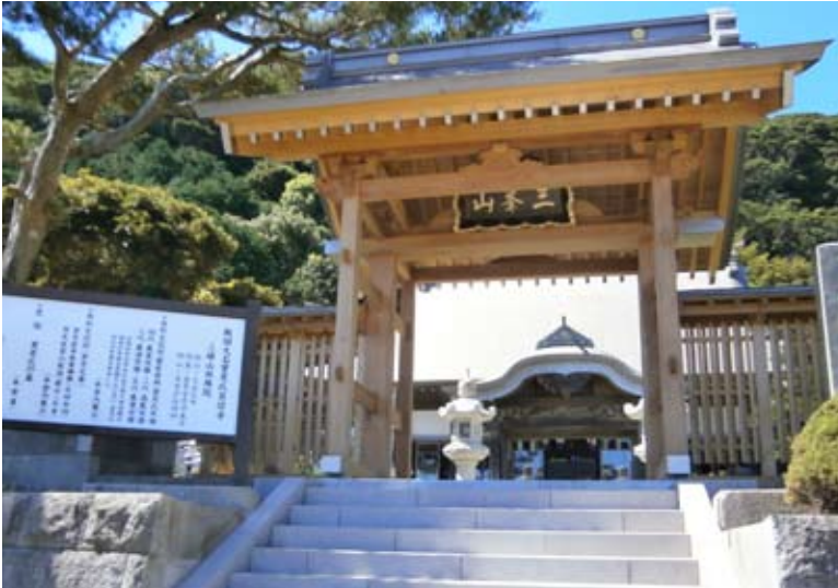
約 360 年ぶりの復元工事、伝統工法を活かしつつチタンの耐食性で末長い継承を期した杖珠院山門（『杖珠院山門復元工事全記録』©KOBO OBA, Kaori Sanuki 2012 より抜粋）
