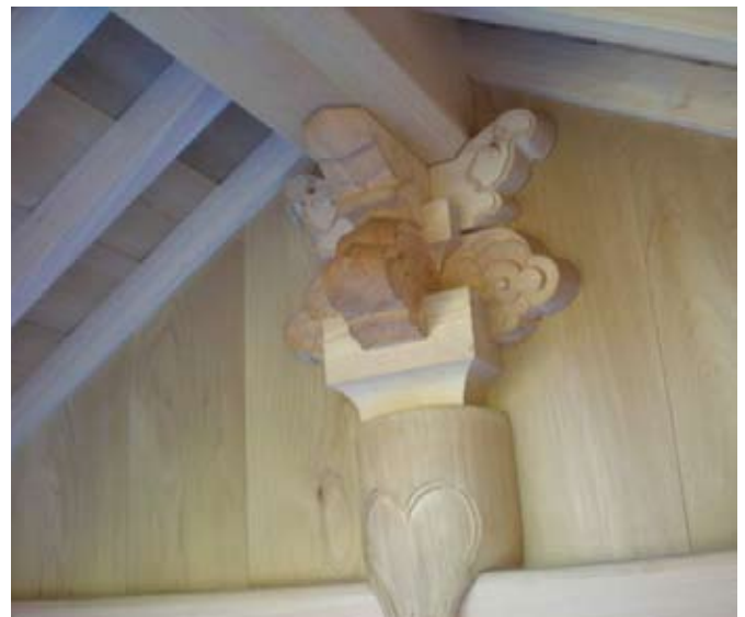
基本的には在来の木組で強度を追求。組物も忠実に再現された。左は旧山門、右は復元された山門（『杖珠院山門復元工事全記録』© KOBO OBA, Kaori Sanuki 2012 より抜粋）
