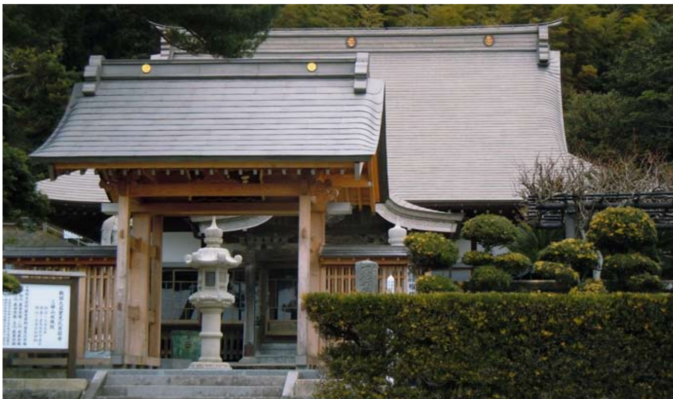
山門越しに本堂を望む。丹念に施工されたチタン屋根が並ぶ姿はまさに壮観
