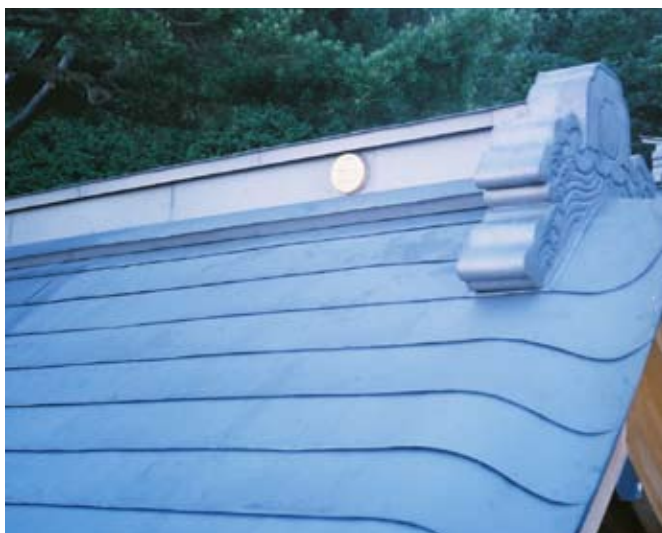
銅板の腐食が進んだ復元前の山門屋根（左）とチタンで葺かれた復元後の山門屋根（『杖珠院山門復元工事全記録』©KOBO OBA, Kaori Sanuki 2012 より抜粋）
