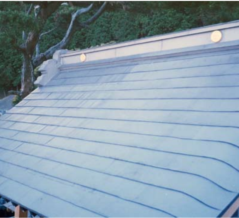
山門の屋根はオールチタン。破風には強風の圧力を逃がす工夫が。箕甲の納まりの美しさに注目（『杖珠院山門復元工事全記録』© KOBO OBA, Kaori Sanuki 2012 より抜粋）
