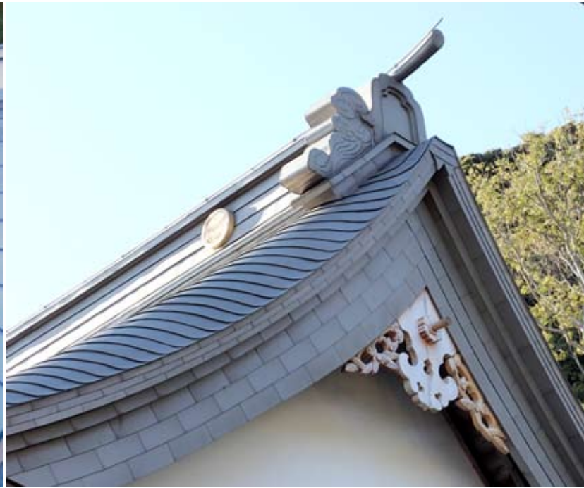
山門の屋根はオールチタン。破風には強風の圧力を逃がす工夫が。箕甲の納まりの美しさに注目（『杖珠院山門復元工事全記録』© KOBO OBA, Kaori Sanuki 2012 より抜粋）
