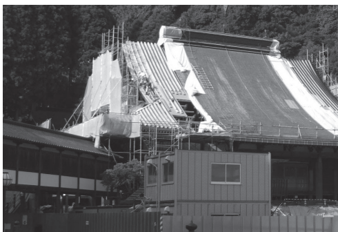
チタン成形本瓦著名寺社屋根改修 (小野工業所)
