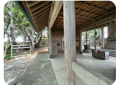
に 拝殿は広くオープンな半屋外空間
