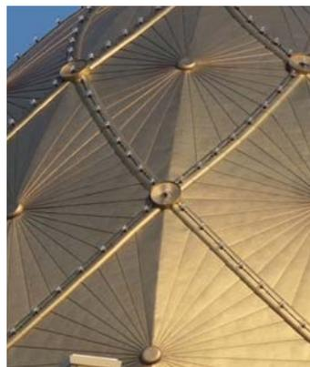
ゴールド発色チタン施工例。発色の美しさとともに、チタンの加工性を実証
