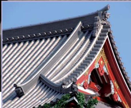
上は3000平方メートルを超える大屋根をチタン本瓦で施工、屋根重量を約930トンから約180トンに低減した浅草寺本堂。左はチタン本瓦葺の先がけとなり、鬼飾りもチタンで製作した浅草寺宝蔵門
