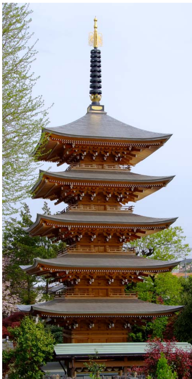
小野工業所様施工事例 傳乗寺五重塔
