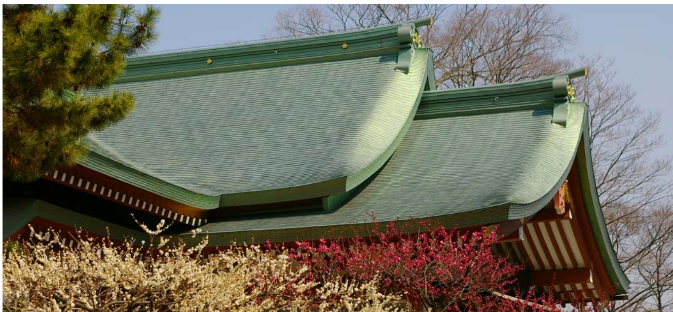
小野工業所様施工事例 北野天満宮宝物殿
