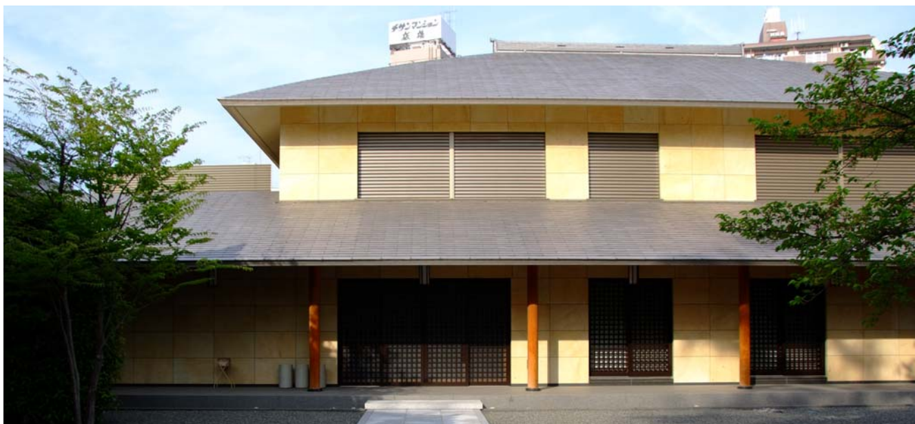
小野工業所様施工事例 智清寺
