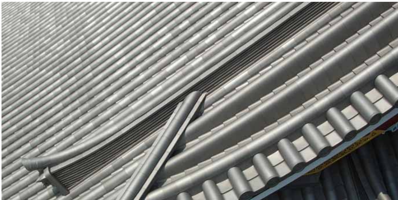
苦心の末、新工法と従来工法の融合により葺き上げられた浅草寺宝蔵門のチタン本瓦屋根。本物の瓦屋根と比べても違和感がない
