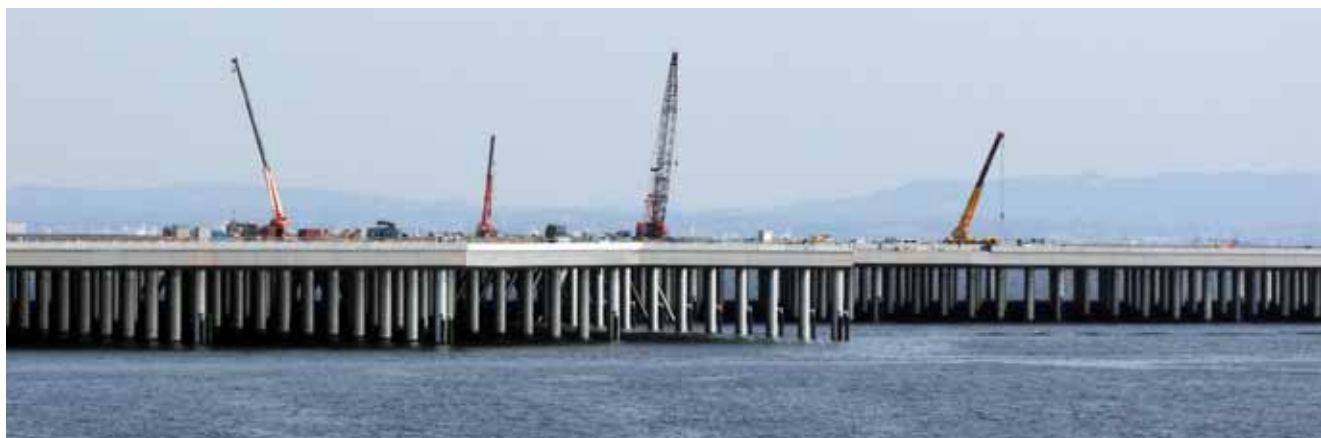
羽田空港D滑走路。建設分野ではチタン適用の最大規模となった工事風景
