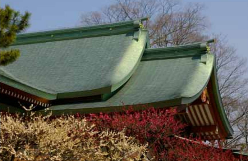
北野天満宮・宝物殿。陽極酸化法により、緑青の色・風合いを再現
