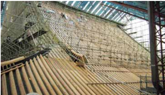
着々と工事が進む浅草寺本堂屋根の改修事業
