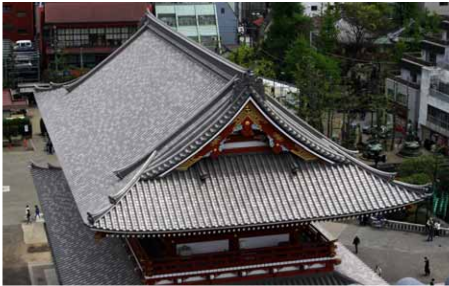
土瓦の質感を出すため、2種類の色のチタン瓦で色ムラをつけた宝蔵門屋根
